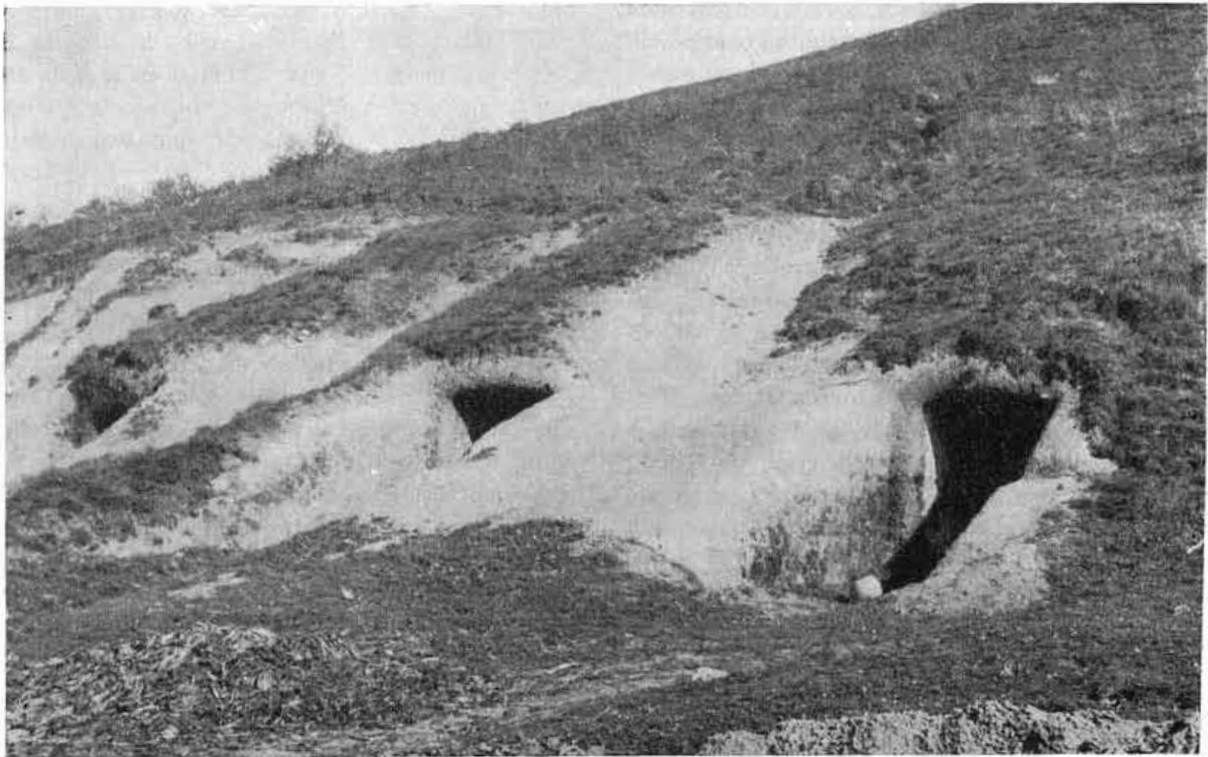
2. Rad pivníc vyhlbených do tufovej horniny. Rykynčice.
