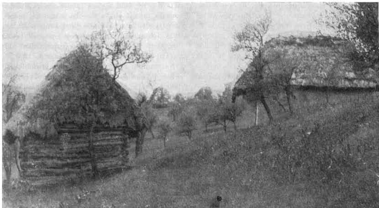
12. Murovaná vínna pivnica s prešovňou, oproti nej zrubová chyžka s obytnou miestnosťou a maštaľou. Devičie.
