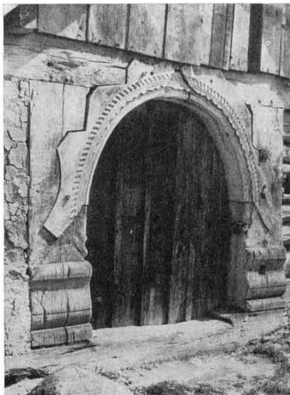
13. Kresaná zárubeň dverí na zrubovej chyžke z polovice 18. stor. Ladzany.
