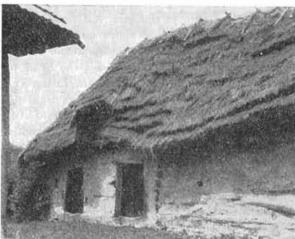
11. Tá istá chyžka — zadná časť budovy s maštaľou a obytnou miestnosťou. Hont. Nemce.
