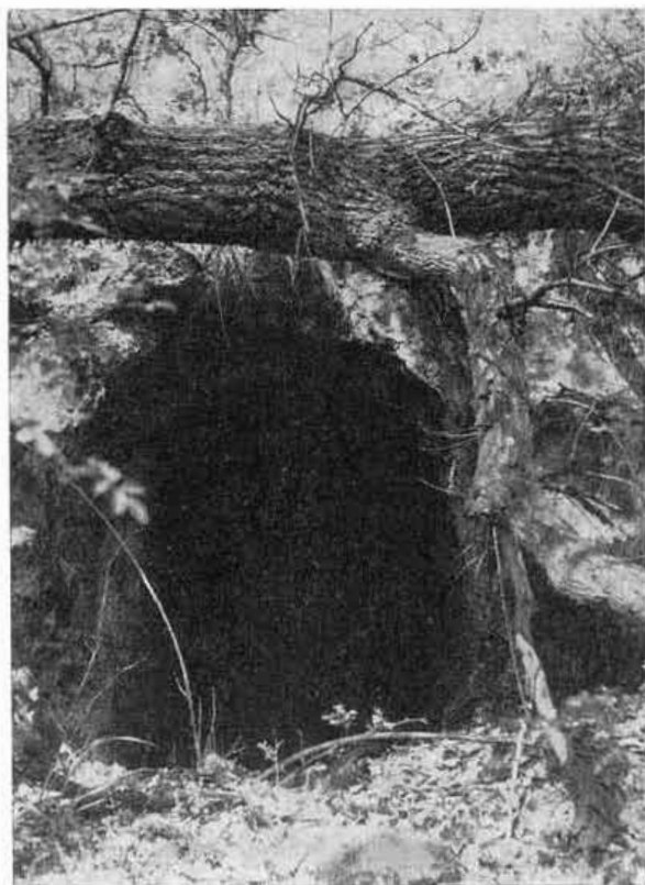
4. Stará zaplavená pivnica v lesnej húšťave. Drieňovo.
